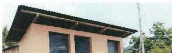
FOTO 8: TECHADO DE INODOROS
