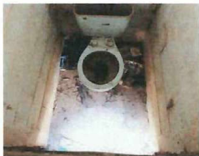
FOTO 1. SUSTITUCIÓN DE 3 SANITARIOS
