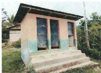
FOTO 4. SUSTITUCIÓN DE PUERTAS DE INODOROS
