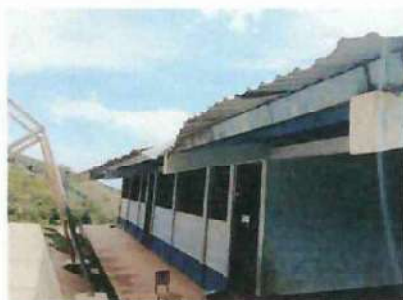
FOTO 5: SUSTITUCIÓN DE LÁMINAS
