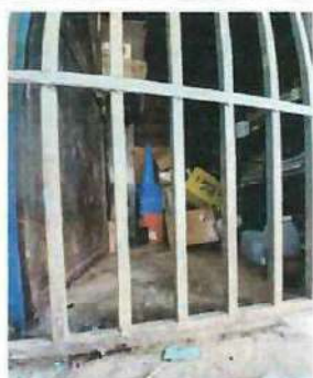
FOTO 9: SUSTITUCIÓN DE PUERTA Y REJAS DE DIRECCIÓN
