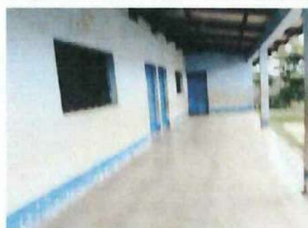
FOTO 10: SUSTITUCIÓN DE PUERTAS
