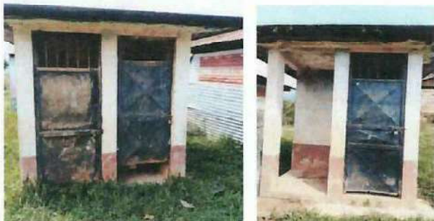
FOTO 7: SUSTITUCIÓN DE PUERTAS DE SANITARIOS
